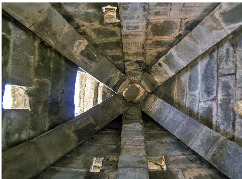
Fig. 4. Bóveda nervada en la capilla superior de la Asunción de Mombuey (foto de José Manuel Rodríguez Montañés).
