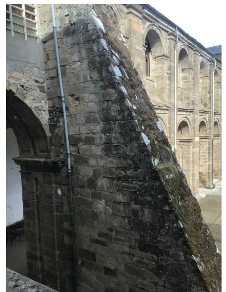
Fig. 53. Contrafuerte con arco embebido en la esquina suroeste del claustro, 2020. Fotografía del autor.
