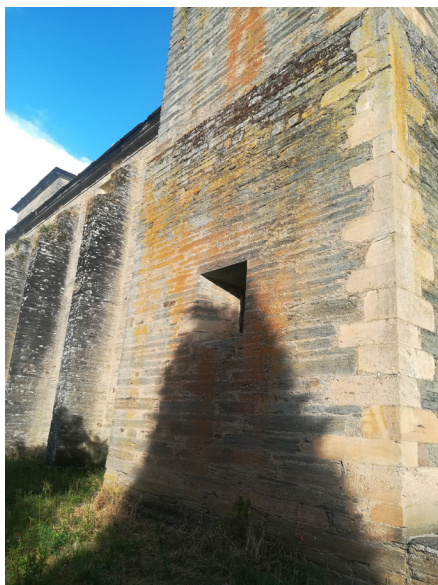
Fig. 67. Vista de la materialidad del templo de San Andrés de Espinareda, en la base de una de las torres de la fachada, 2020. Fotografía del autor.
