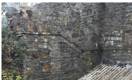
Fig. 59. Vista de la roza existente en el muro en la esquina sureste donde se ubicaba la escalera, 2020. Fotografía del autor.
