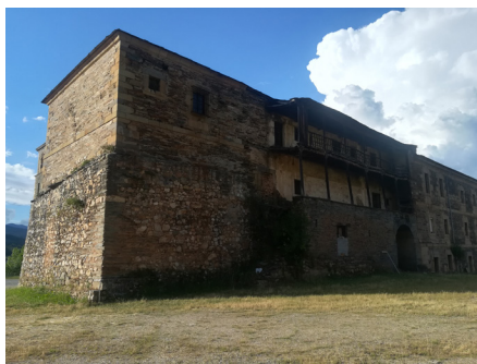
Fig. 79. Vista de la "casa del cura", actualmente en reforma, en la esquina suroeste del monasterio de San Andrés de Espinareda, 2020. Fotografía del autor.
