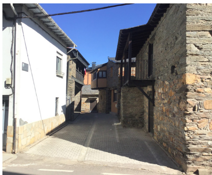
Fig. 28. Algunas viviendas tradicionales del Barrio de la Pallosa, 2020. Fotografía del autor.
