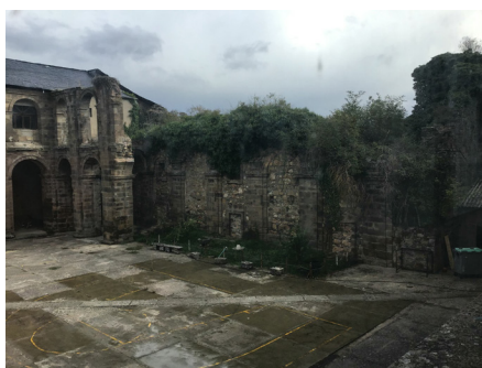
Fig. 64. Vista del ala este del claustro, con dos arquerías y dos muros en estado de ruina cubiertos por vegetación, 2020. Fotografía del autor.
