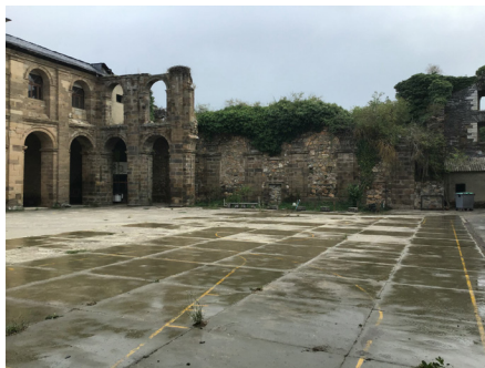
Fig. 39. Vista del estado incompleto del ala este, que solo presenta dos arquerías en la esquina noreste del claustro del monasterio de San Andrés de Espinareda, 2020. Fotografía del autor.
