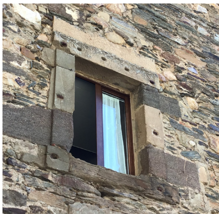
Fig. 41. Vista de una de las ventanas que presentan huecos en las jambas por haber contado con rejas hasta la etapa de abandono, tras la desamortización, 2020. Fotografía del autor.
