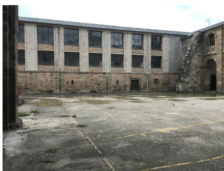
Fig. 40. Vista del estado actual del ala sur sin pasillo perimetral soportado, y contrafuerte en la esquina suroeste, 2020. Fotografía del autor.
