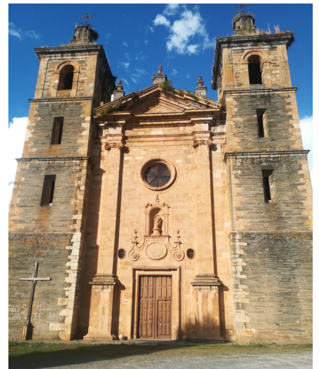
Fig. 51. Vista de la fachada de la iglesia, 2020. Fotografía del autor.
