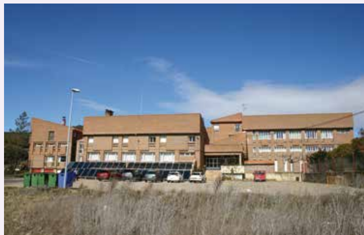
Exterior del colegio
