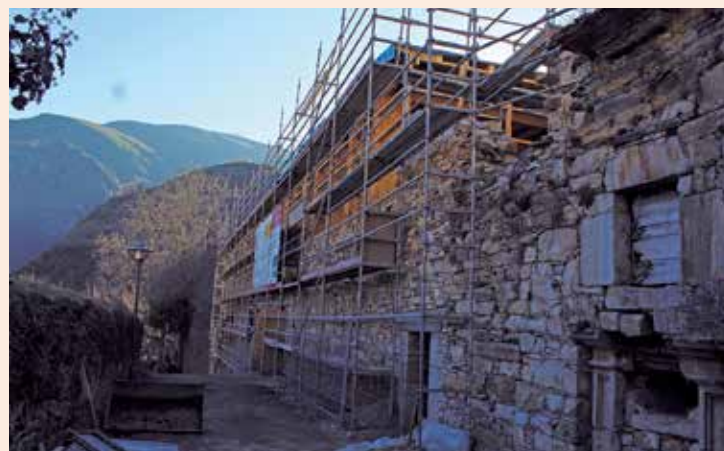
Estado actual de las obras
